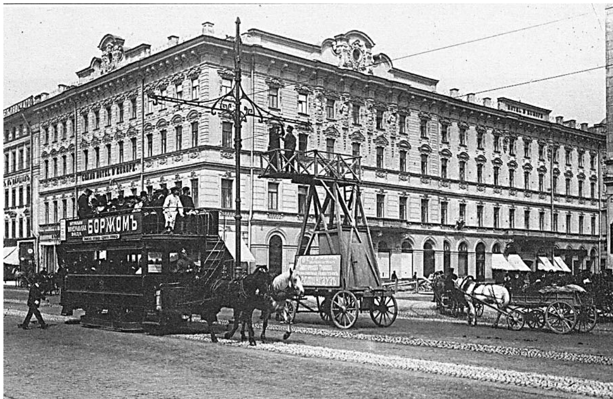
Рис. 4. 1907 г. Укрепление электропроводов для трамвайного движения на Невском проспекте. Хорошо видна торцевая мостовая[2]. Фото К. Буллы (URL: http://pics2.pokazuha.ru/p217/4/4/8287937d44.jpg )
