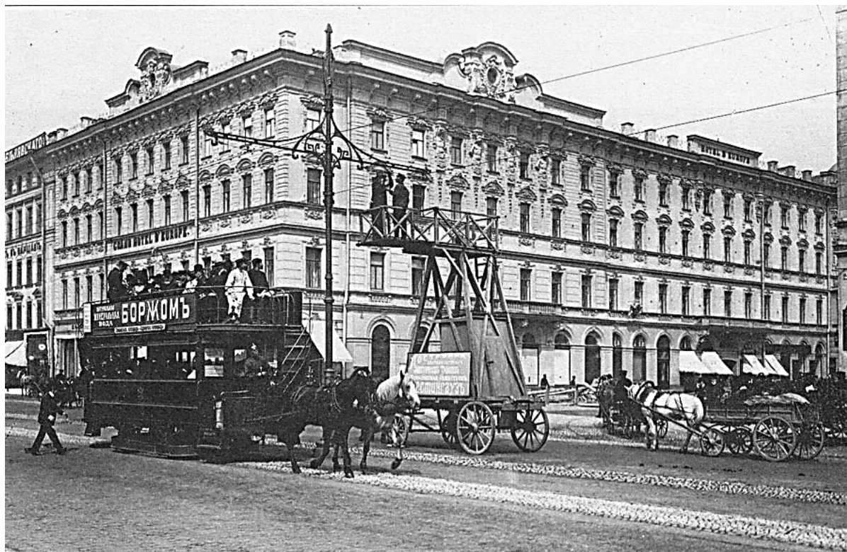
Рис. 4. 1907 г. Укрепление электропроводов для трамвайного движения на Невском проспекте.
